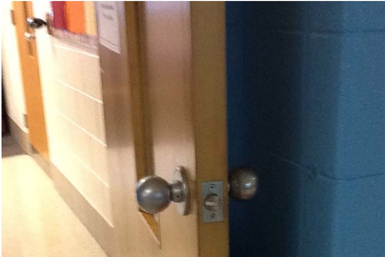
Door handles not ADA compliant.
